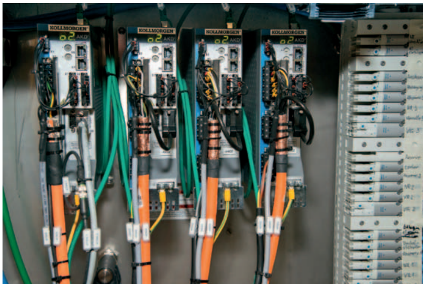
I servoregolatori AKD di Kollmorgen sono collegati ai motori tramite tecnologia a cavo singolo
