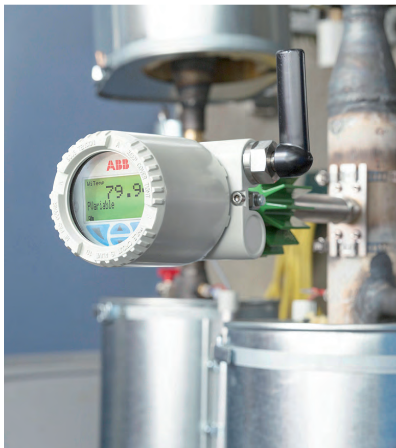
Fig. 1 - Sensori dovunque - Nodi sensori wireless a bassa potenza alimentati in perpetuo tramite la tecnologia energy harvesting, come questo sensore di temperatura wireless di ABB alimentato con energia termica accumulata, possono essere collocati in modo ottimale per acquisire ulteriori dati in un ambiente industriale
