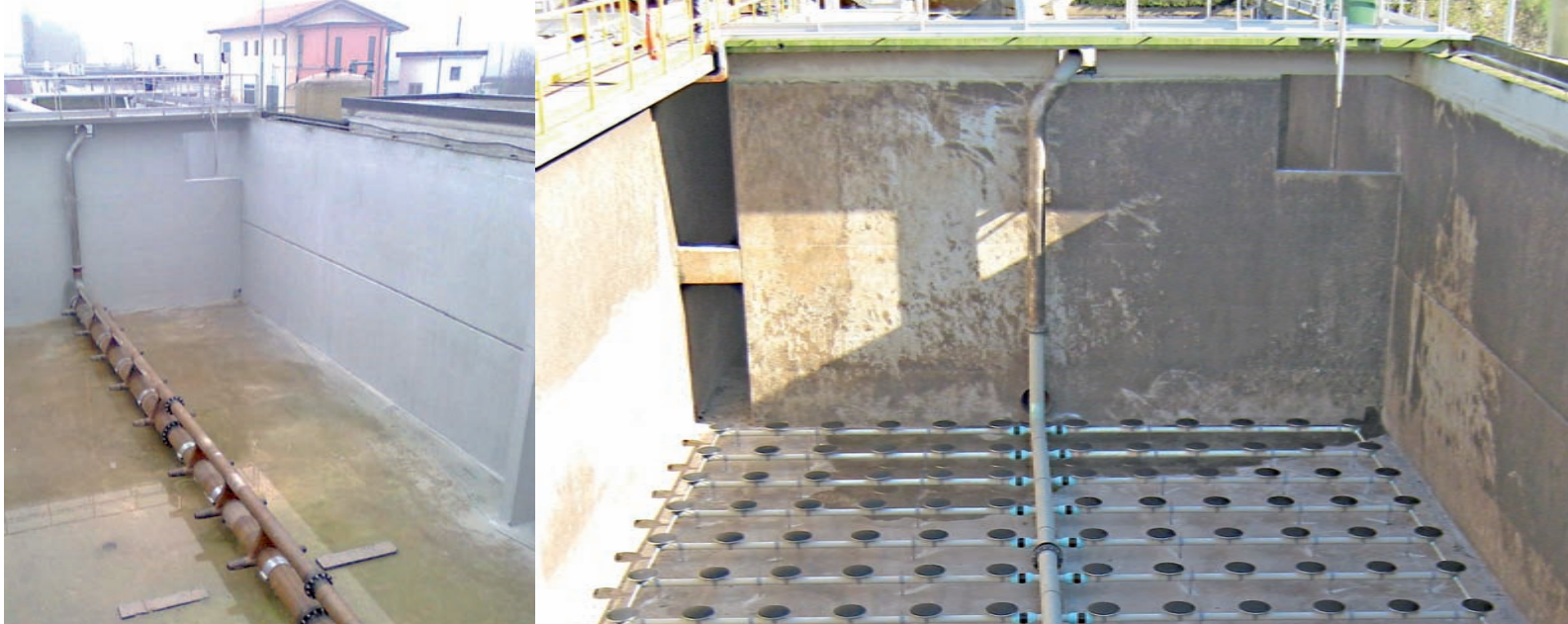
Figura 3 – Sistema di ossidazione prima [A] e dopo [B] l'intervento.
