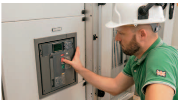
Gli interruttori automatici sono stati dotati di sensori e sono stati connessi al cloud di Microsoft Azure
