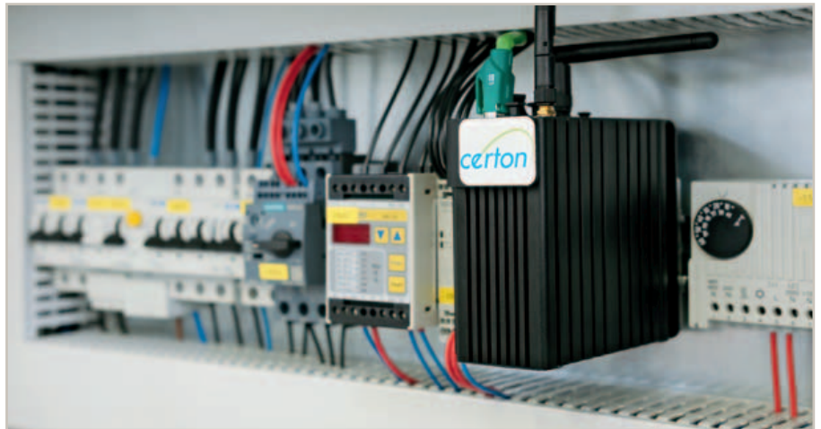
Benninger Automation impiega il prodotto modulare certon per la raccolta, registrazione, visualizzazione e inoltro dei dati da sistemi di controllo o Scada
