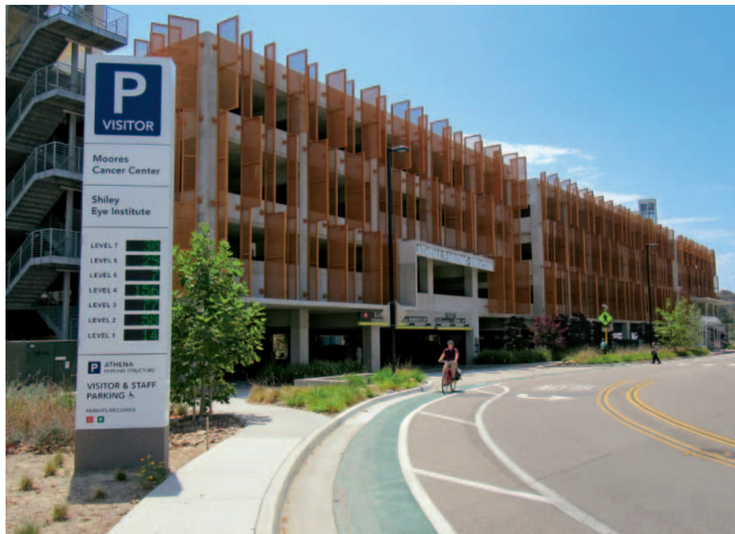
Nel parcheggio dell'Università della California di San Diego finora sono stati equipaggiati con i sensori Tinynode quasi 230 stalli
